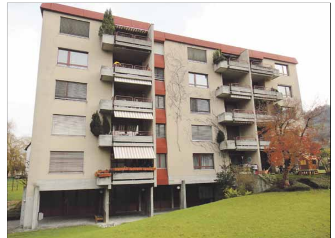
Architekt Marcel Neuenschwander: «Nach 30 Jahren war eine Aufwertung nötig.»
