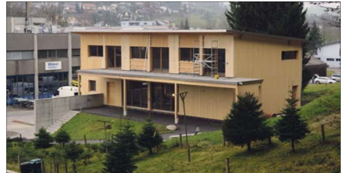
Mittlerweile ist das neue Pfadiheim in Adligenswil nahezu fertig und wurde feierlich eingeweiht.
