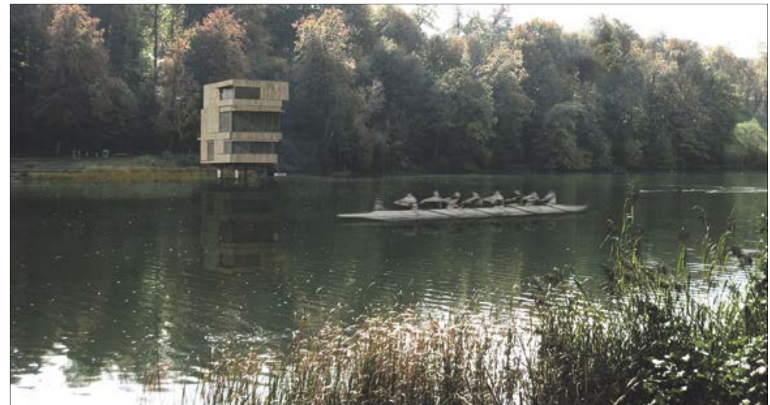
So sieht der neue Zielturm am Rotsee aus, wenn er im kommenden Mai fertig erstellt ist.
