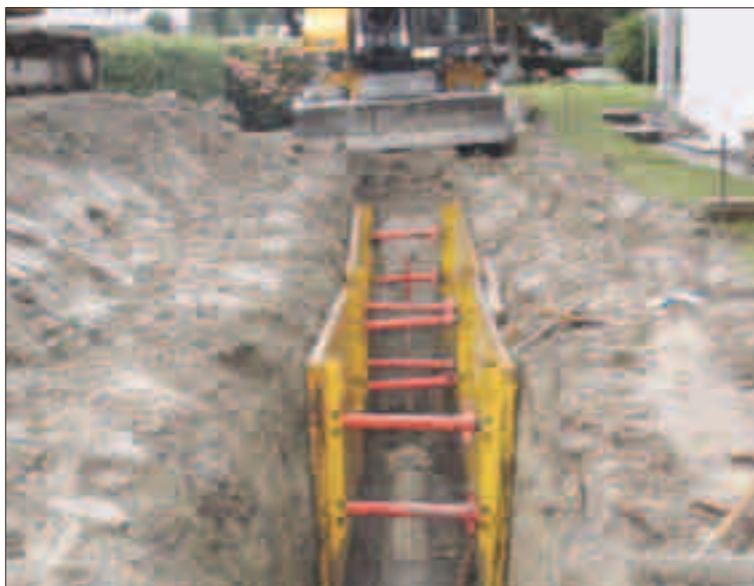
Kanalisationsarbeiten an der Schachenweidstrasse. Bild Wipfli & Partner AG
