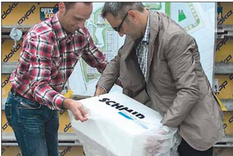
Die Bauleute verpacken eine Dokumentenschatulle mit Plänen sowie der neuste Ausgabe des «Rontalers», welche schliesslich in den Baugrund einbetoniert wurde.
