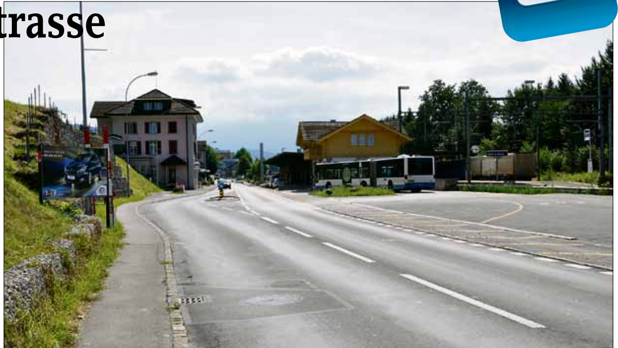
Im Zuge der Sanierung der Kantonsstrasse wird auch die Bushaltestelle und der Buswendeplatz in Root vollständig erneuert und mit Verkehrsinseln versehen.
