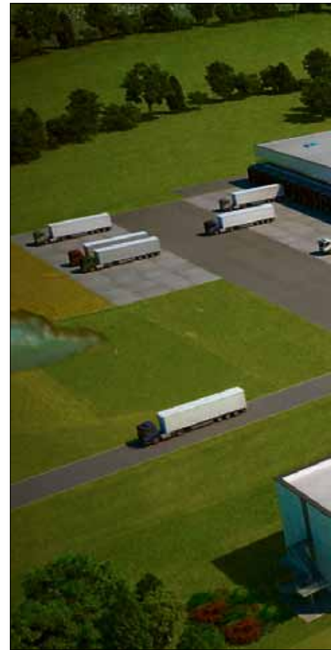
Das geplante Aldi Suisse Verteilzentrum in Root wird für einen Grossteil der Schweizer Filialen
