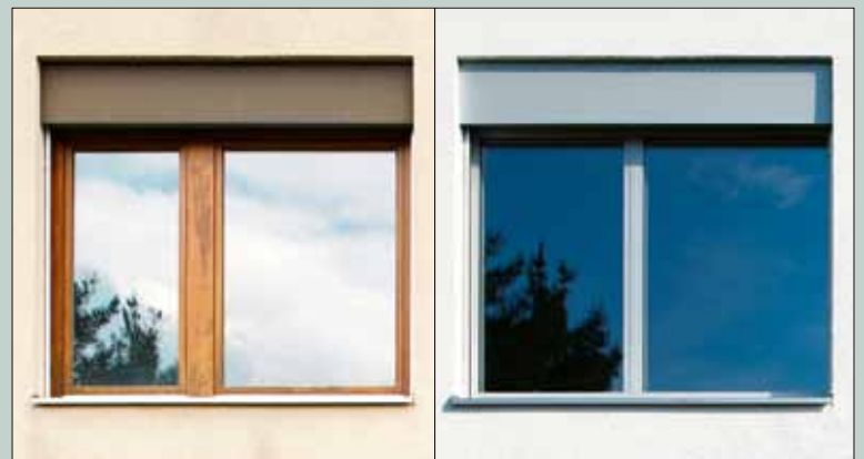
Gut zu sehen, schmale Mittelpartie und -schmale Profile nach der Sanierung.
