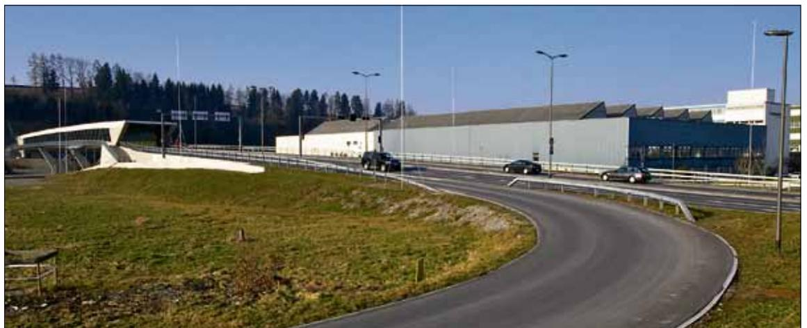
Beim Teilabschnitt Tunnelausfahrt bis zur Lichtsignalanlage wird ein lärmdämmender Strassenbelag gefordert.
