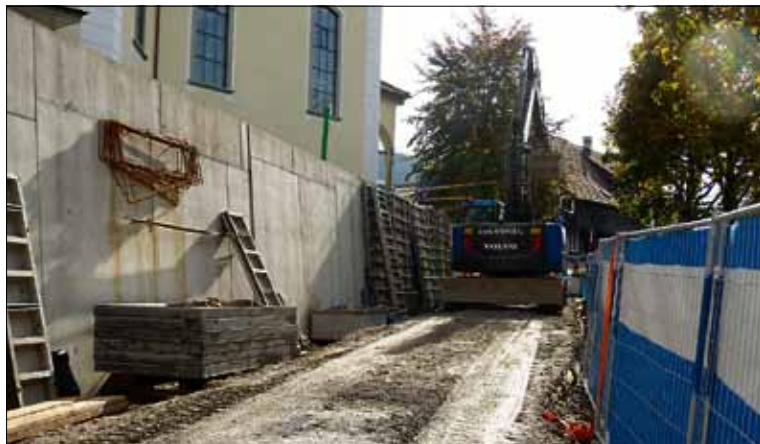
Die neue Betonmauer... und ein intaktes Stück der alten Mauer aus feuchtigkeitsresistentem Kieselkalkstein.
