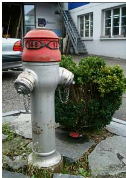
Die Hydranten werden revidiert.
