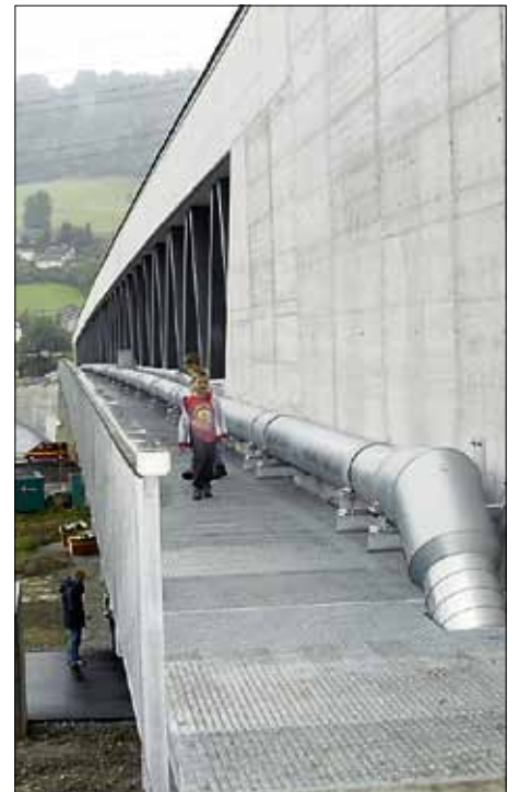
Auch im Freien gibts Fluchtwege.
