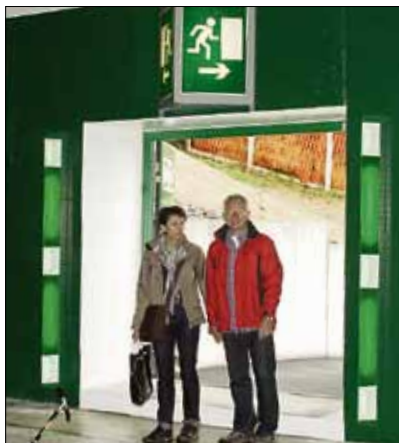
Im Abstand von jeweils 22 Metern sind Fluchtwege signalisiert.
