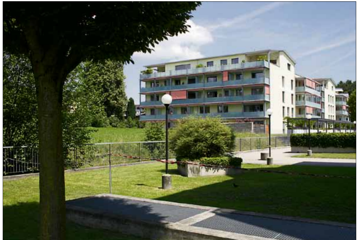
Ab 2012 wird die 3. Etappe des Zentrums Tschann gebaut.
