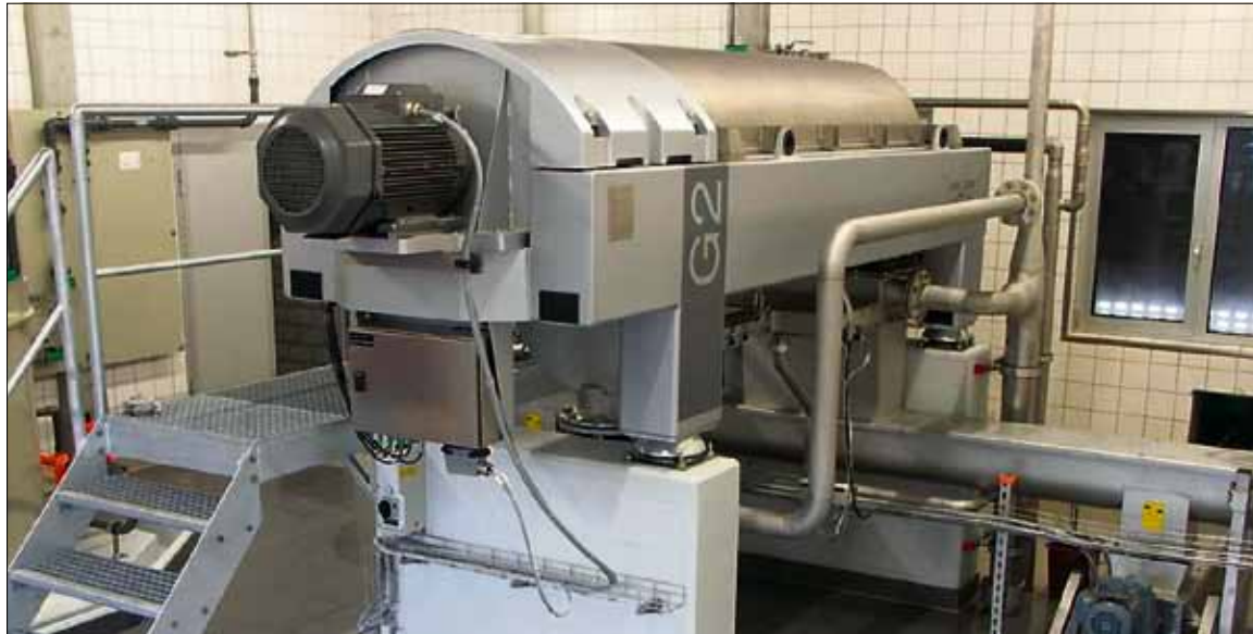
Dank dem neuen Dekanter konnte der Faulschlamm von 650 auf 550 Tonnen reduziert werden.
