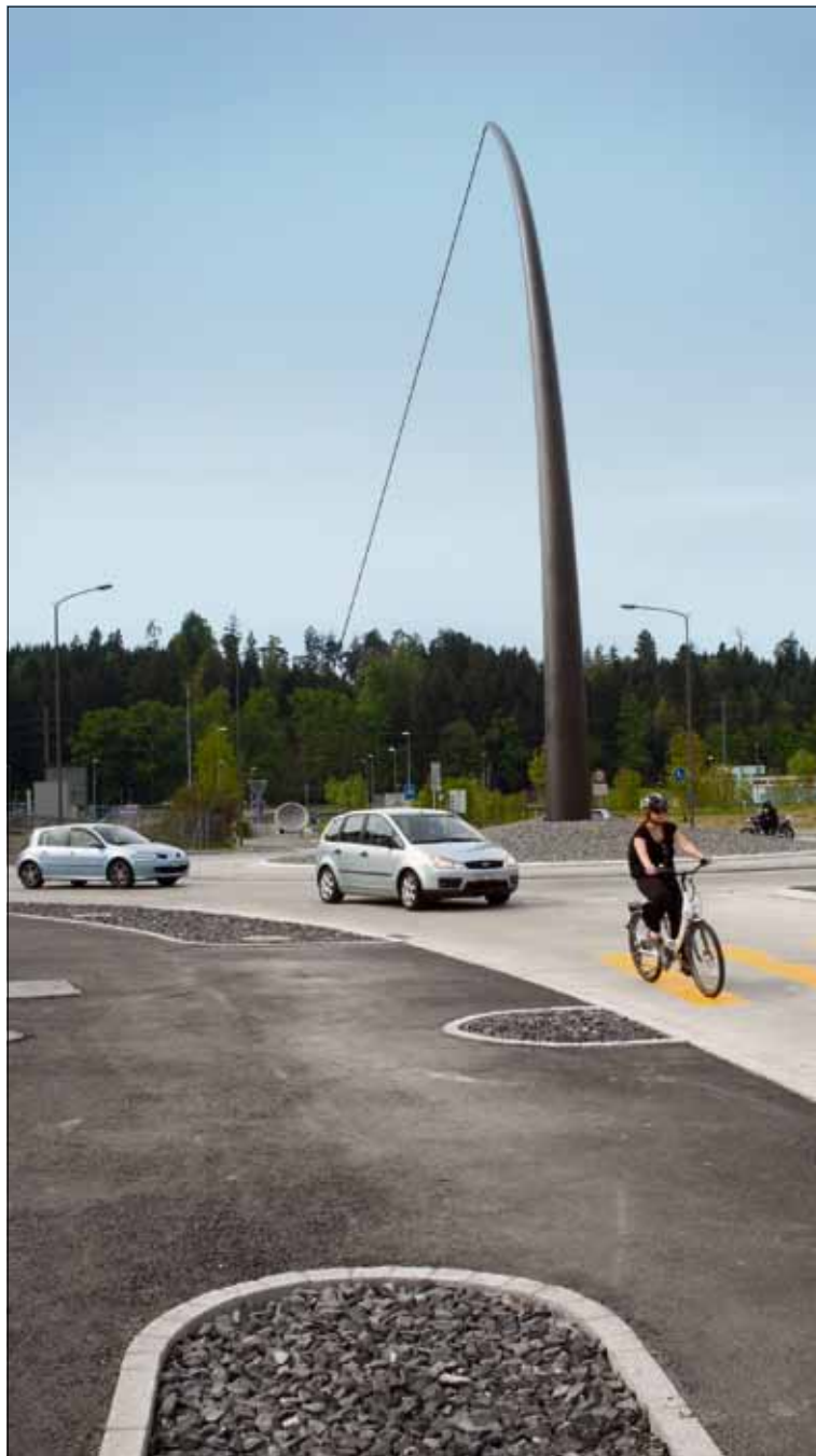
Die Stahlnadel auf der Hauptstrasse in Root erscheint aus einem Guss, ist sie aber nicht. Bild Lars de Groot
