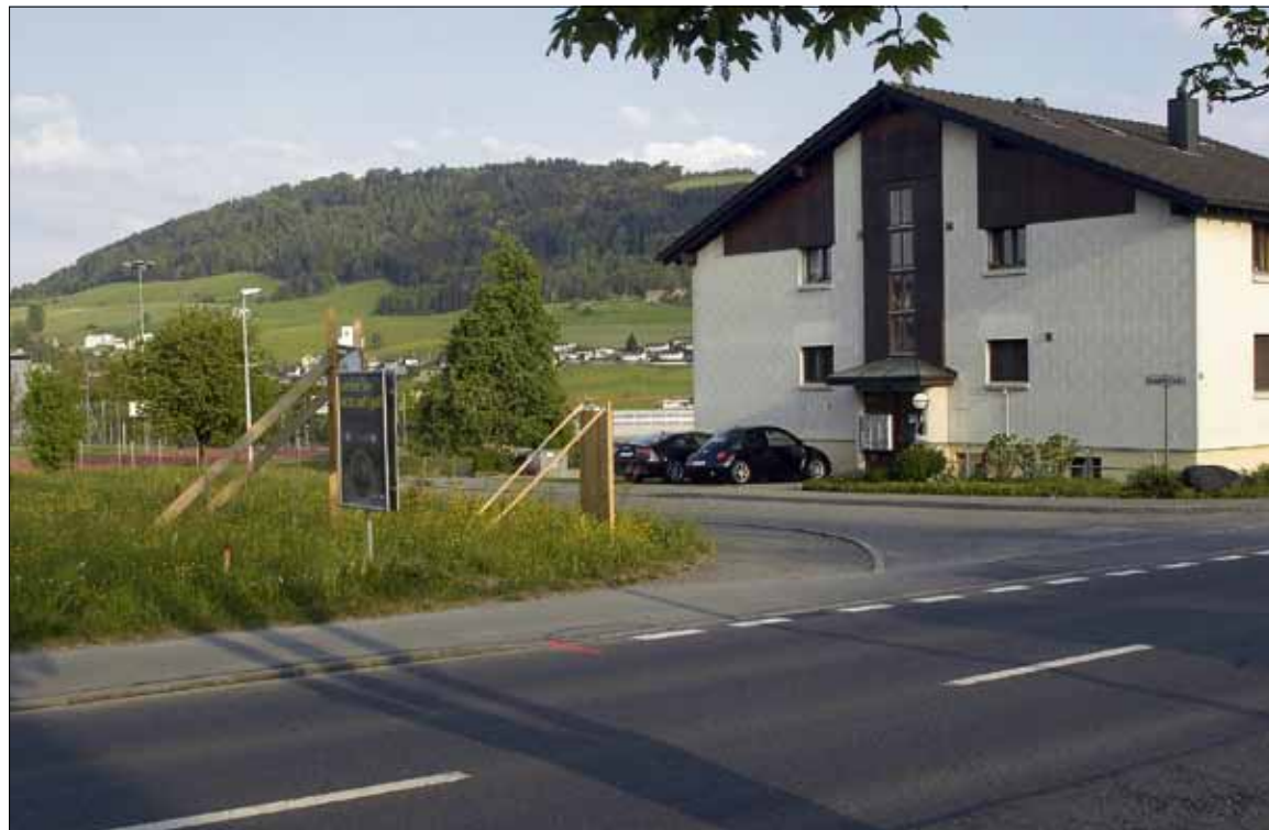
Bei der Einmündung zur Leumattstrasse (rechts im Bild) werden als flankierende Massnahmen zwei Mittelinseln für ein sogenanntes Portal erstellt. Auf dem Wiesengrundstück (links) entsteht der neue Gewerbebau Leumatt.
