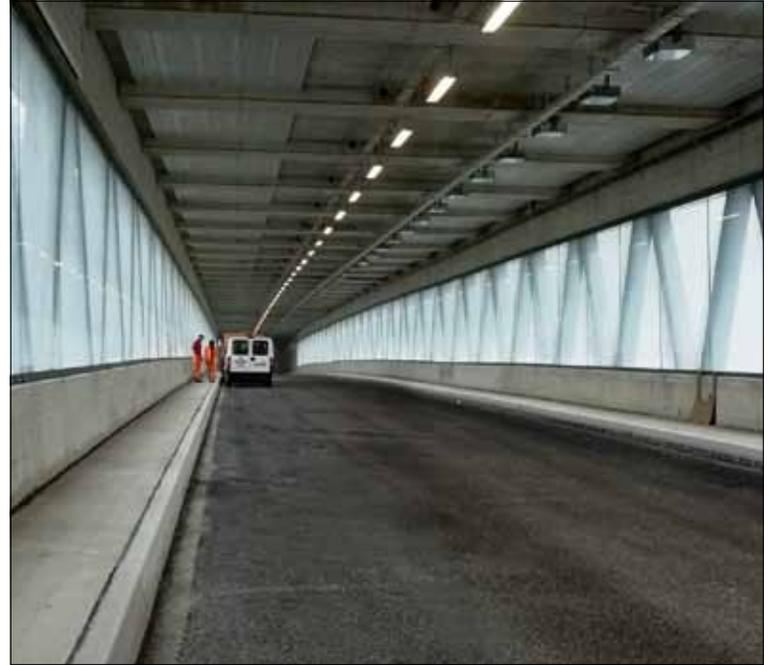
Die eingedeckte Rontalbrücke mit bereits installierter Beleuchtung.
