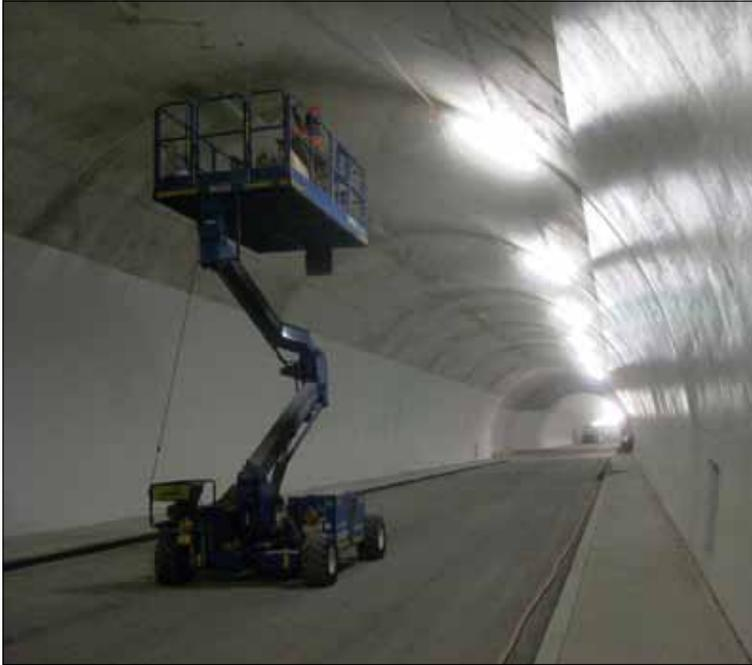
Das Tunnelgewölbe ist fertig betoniert und die Montagearbeiten der Installationsfirma haben begonnen.
