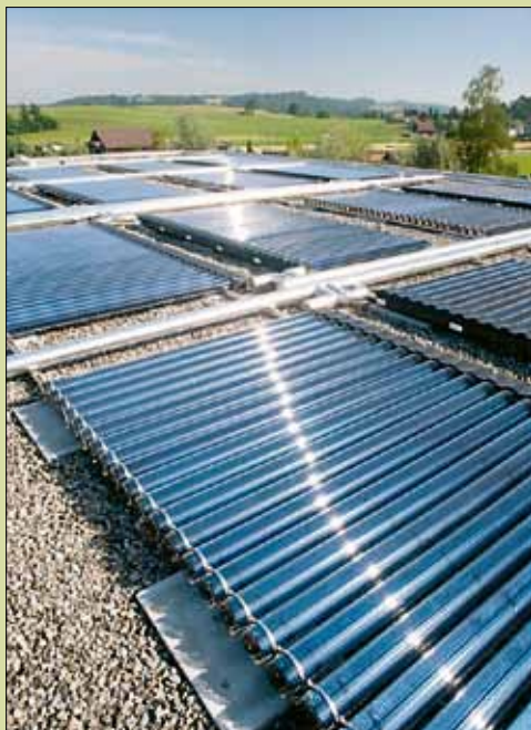
Solaranlage auf dem Dach der Kerzenfabrik Fischer in Root. Bild pd
