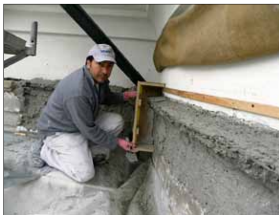
Reparaturarbeiten am Verputz mit einer Schablone.
