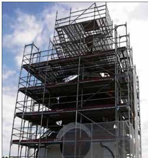
Der eingerüstete Turm.
