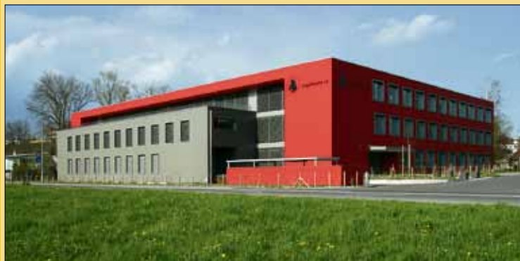
Der Neubau für Vogelkunde und Vogelschutz wird die Arbeit der Schweizerischen Vogelwarte Sempach auf Jahrzehnte hinaus beflügeln.
