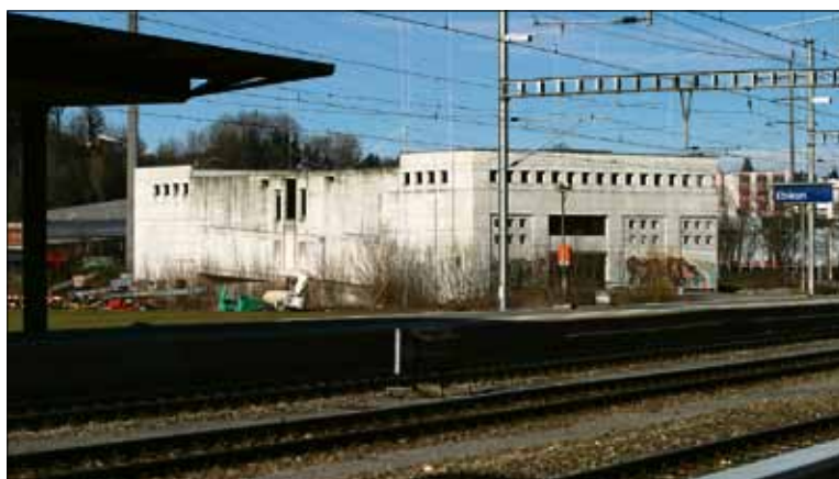
Der Gemeinderat von Ebikon propagiert das Grundstück beim «Bunker» als Standort für das künftige Kantonsgerichts-Gebäude. Ist da beim S-Bahnhof der Zug schon abgefahren? Bilder Lars de Groot
